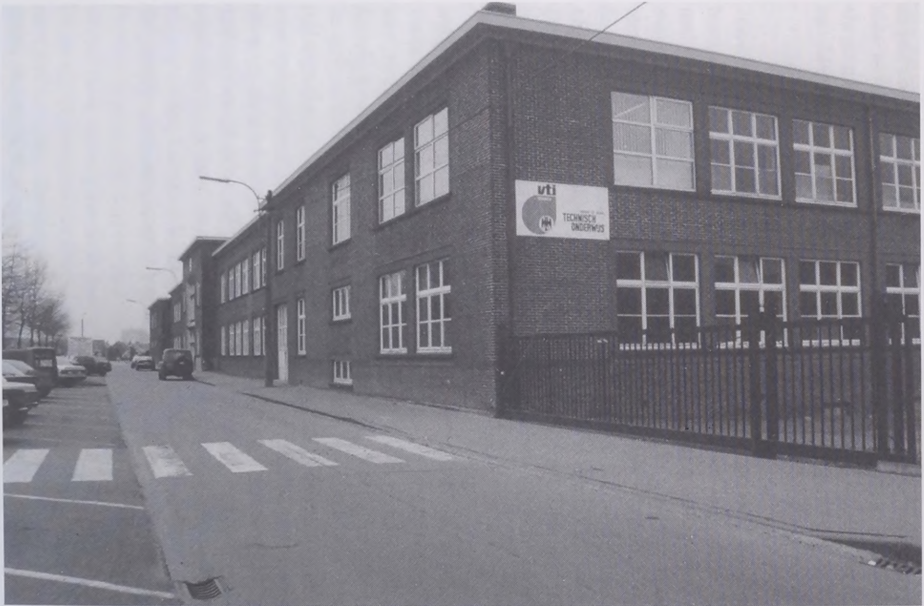
Het V.T.I.-Deinze. Het hekken dat toegang tot de fietskelder geeft. Daar eindigde en begon de dagelijkse rit van de leerling-flandriens van huis naar school en van school naar huis. (Foto V.T.I.-Deinze)
